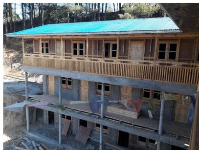
Le deuxième étage est fermé, les portes et fenêtres sont posées, le bâtiment est hors d'eau. Les travaux d'intérieur peuvent commencer.
